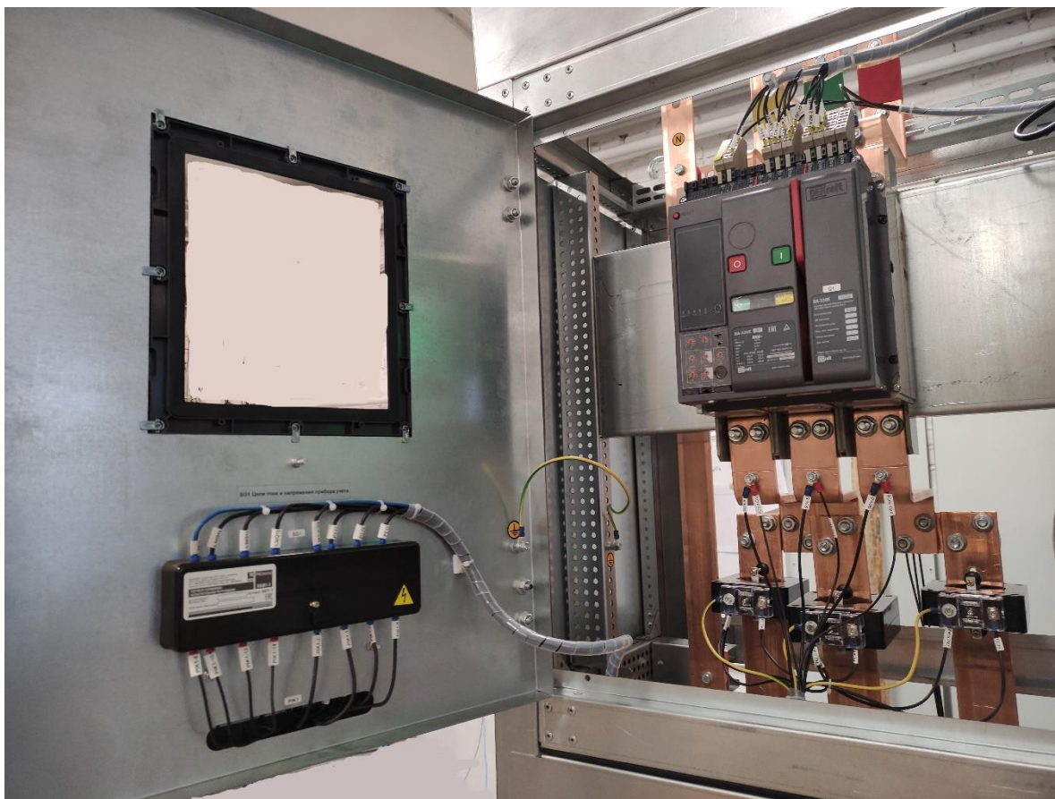
Рис. 2. Вариант отсека выключателя ШРН стационарного исполнения
