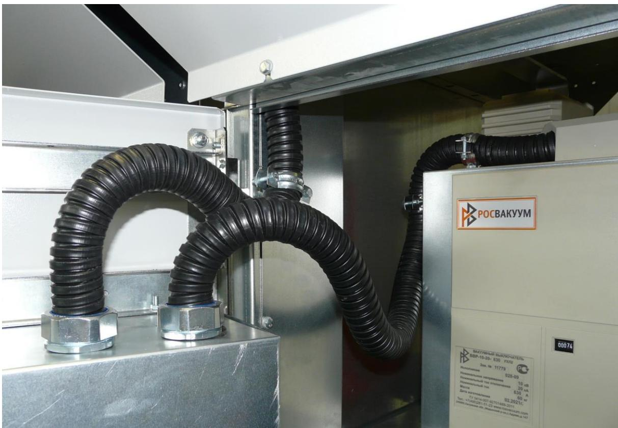
**Рис. 11. Металлорукав для прокладки жгутов проводников вторичных цепей**
