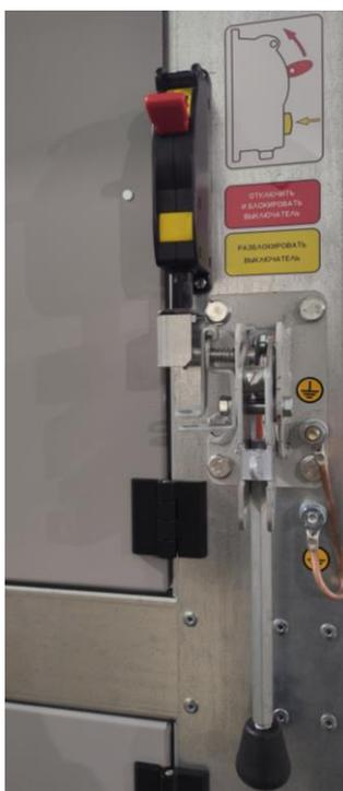
**Рис. 6.4. Механическая блокировка привода ПР-10 от выключателя**
