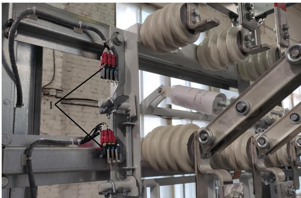
**Рис. 6.3. Размещение блок-контактов на разъединителе РВЗ-10**
