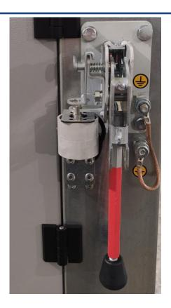
Рис. 6.5. Электромагнитная блокировка привода ПР-10 от замка ЗБ-1
