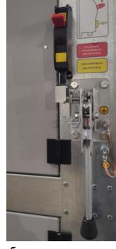
Рис. 6.4. Механическая блокировка привода ПР-10 от выключателя
