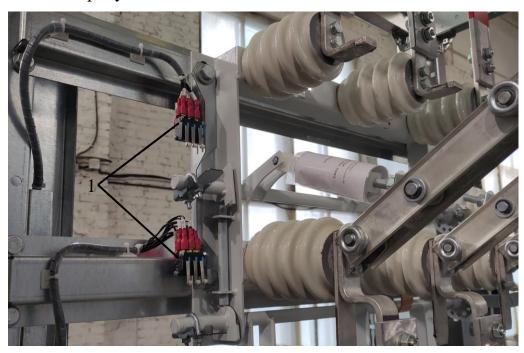
Рис. 6.3. Размещение блок-контактов на разъединителе PB3-10 1 – блок-контакты разъединителя и его заземлителя.
