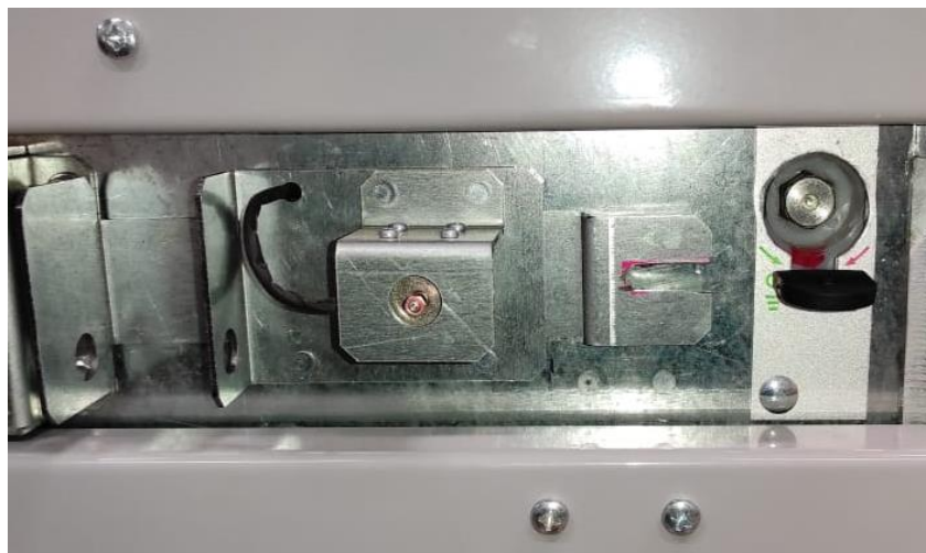
Рис. 10.3 Электромагнитная блокировка (15) привода заземлителя
