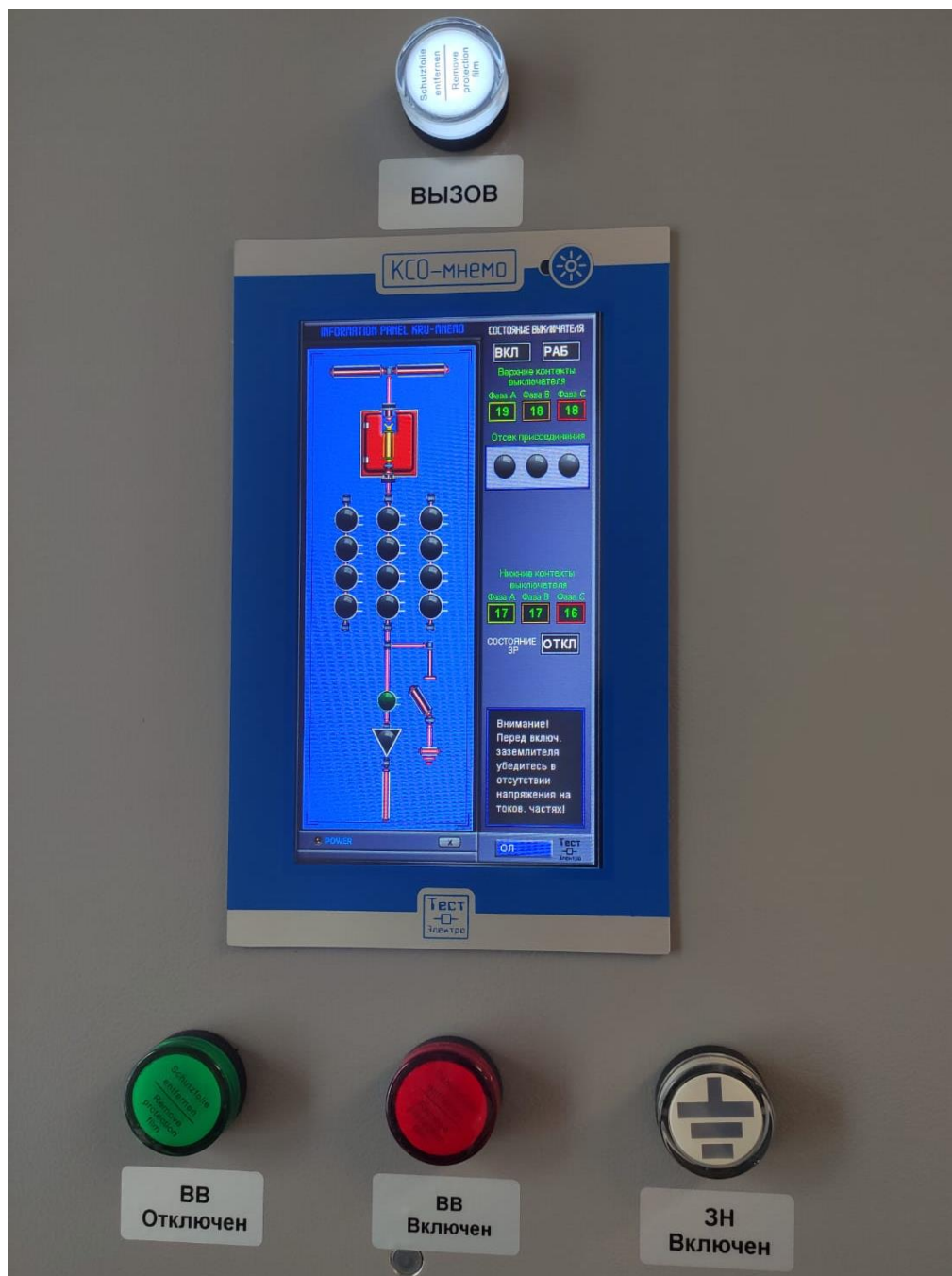
Рис. 4.1 Индикация на двери релейного отсека с ЖК-дисплеем
