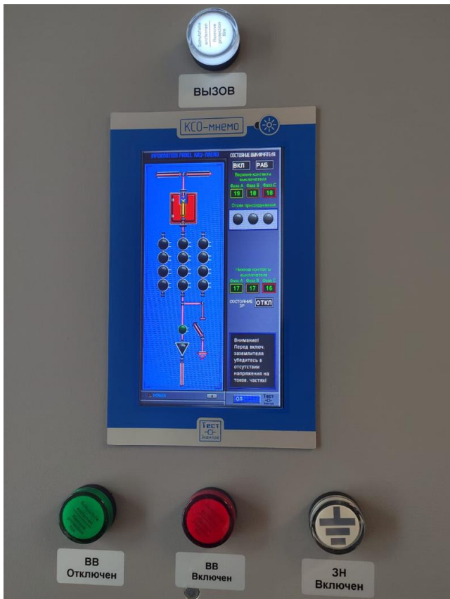
Рис. 6. Индикация на двери релейного отсека
